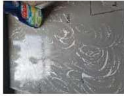
4. Reiniger flächig auftragen
