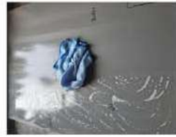
5. Reinigungsrückstände nach Wirkzeit mit heißem Wasser und Mikrofasertuch abnehmen
